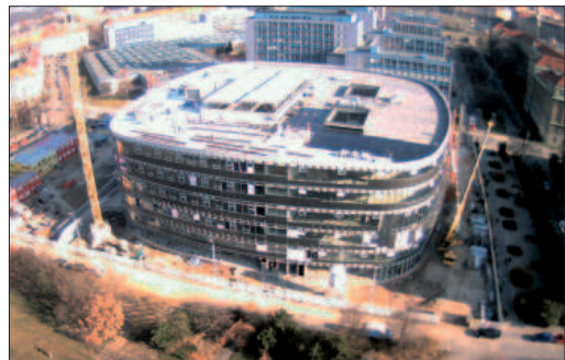
Tak vypadalo staveniště před rokem – 26. února 2008.
