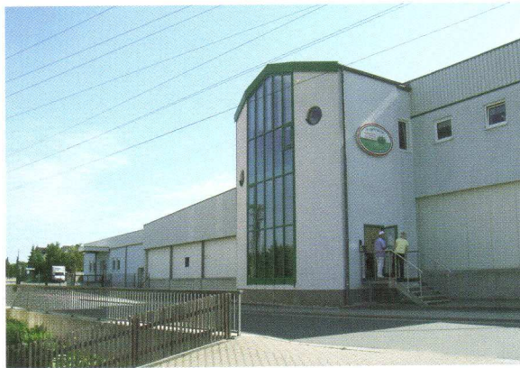
Erweiterungsanbau der Neuwürschnitzer Fleisch- und Wurstwaren AG in Oelsnitz/OT Neuwürschnitz.
